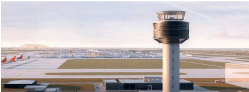
Torre de Control Jorge Chávez del Aeropuerto Internacional
